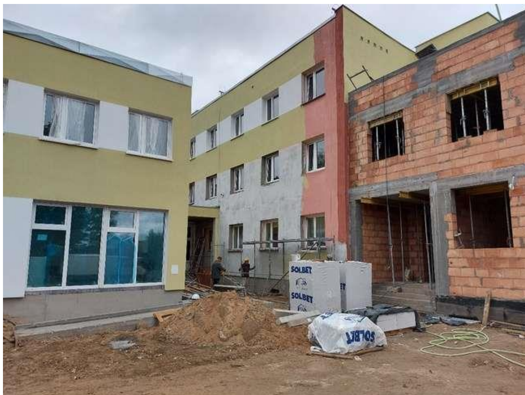
Widok prowadzonych prac
