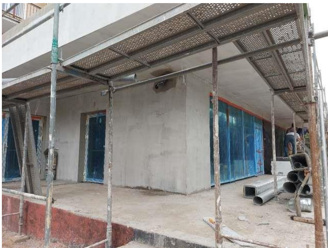
Widok prowadzonych prac
