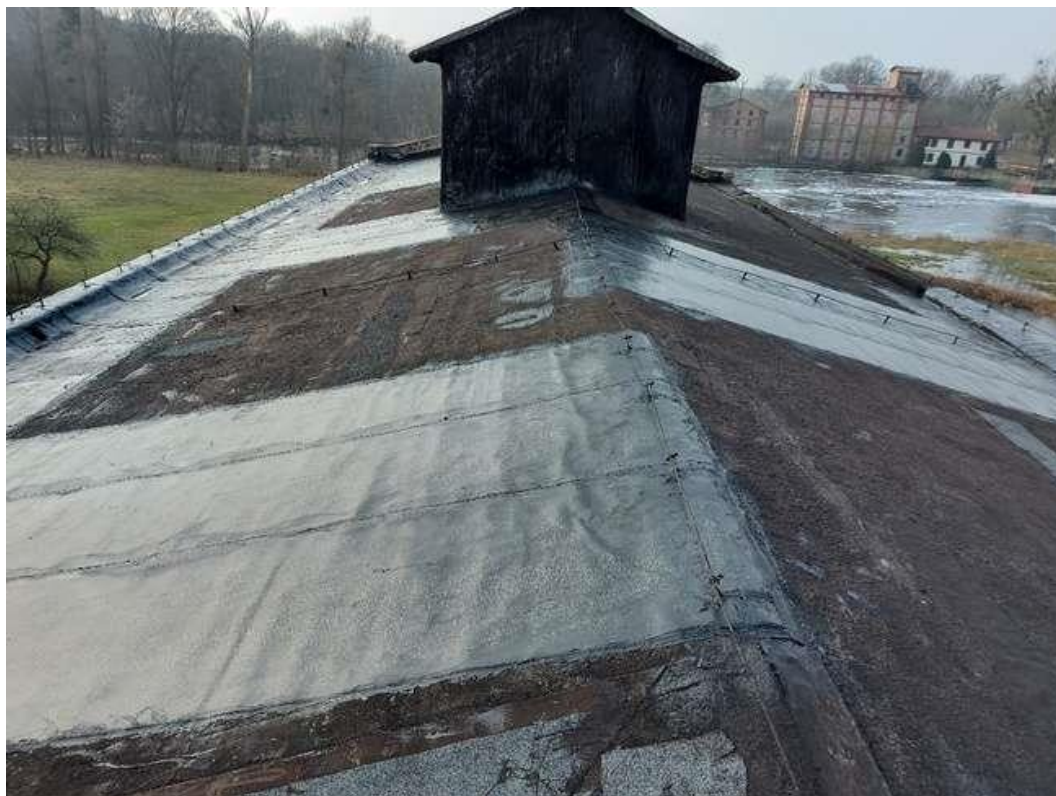
Widok wykonanych prac naprawczych
