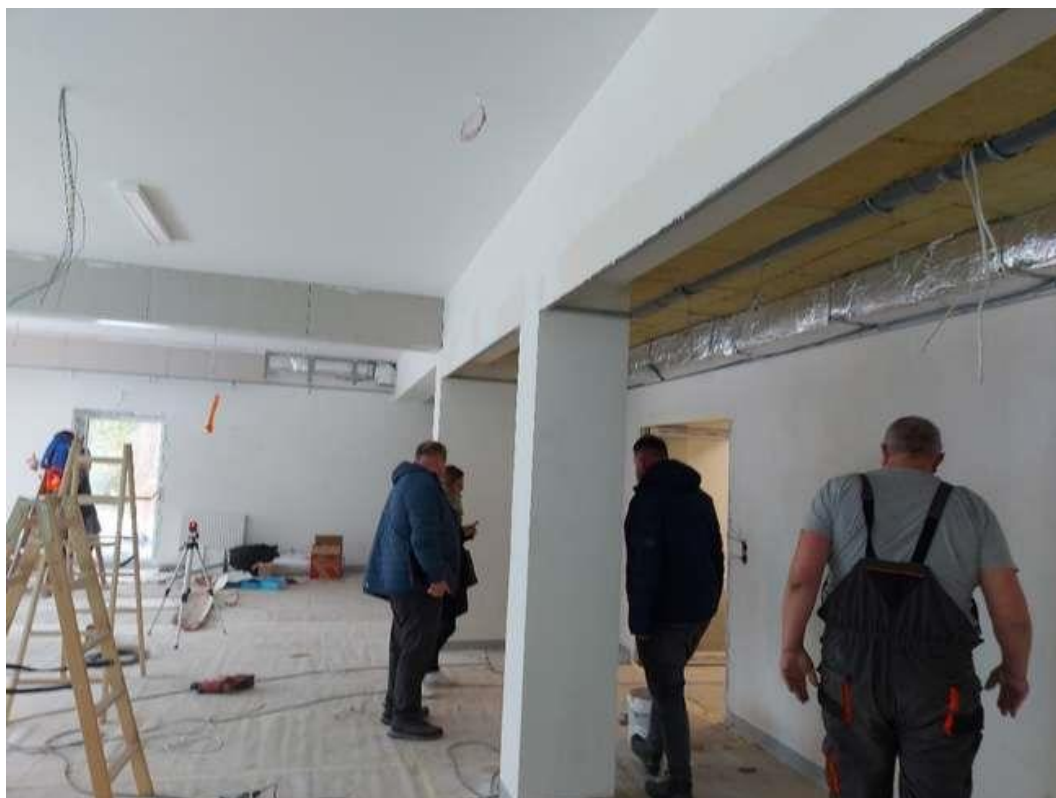
Widok prowadzonych prac
