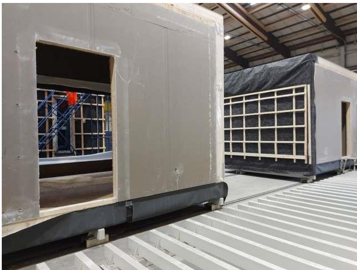
Widok wykonywanych modułów w fabryce
