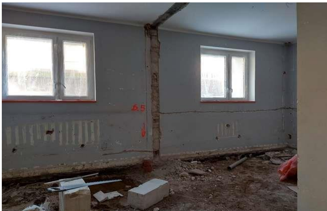
Widok prowadzonych prac
