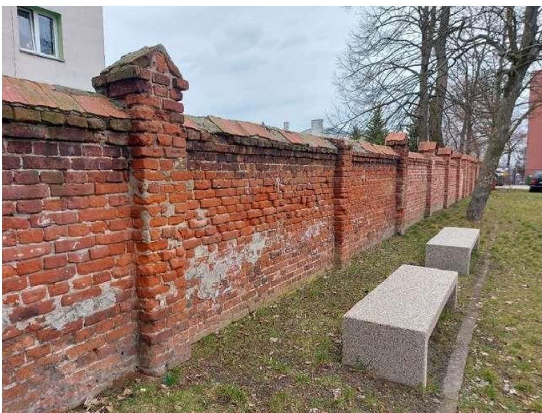
Widok ogrodzenia przed remontem
