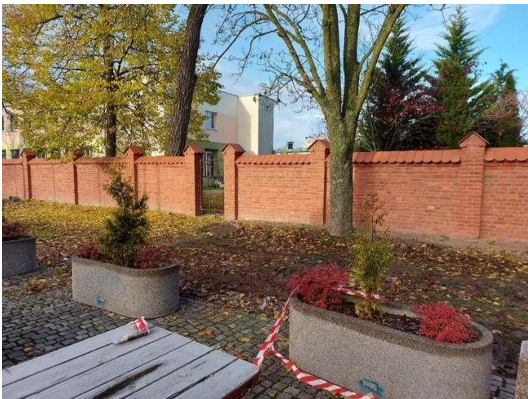
Widok ogrodzenia po remoncie.
