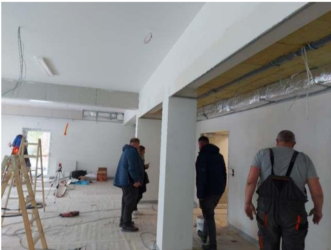
Widok prowadzonych prac
