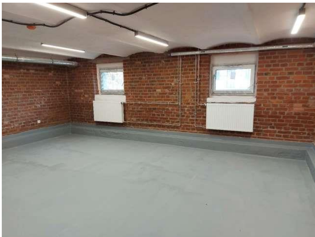
Widok sal piwnicznych po remoncie.
