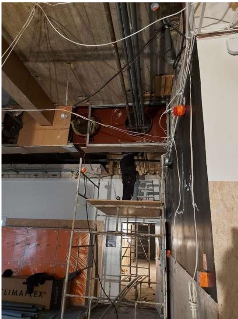
Widok prowadzonych prac
