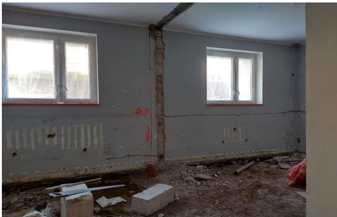
Widok prowadzonych prac
