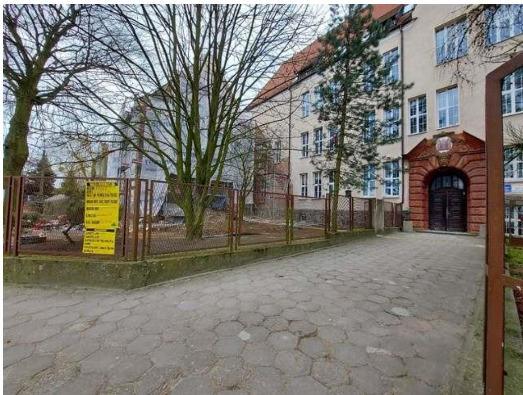
Widok wejścia głównego przed remontem
