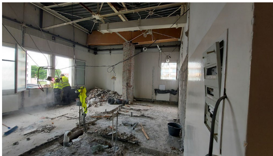
Fot. Widok prowadzonych prac
