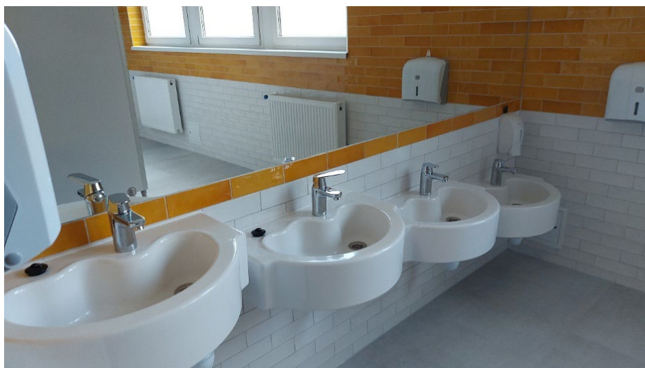
Fot. Widok zrealizowanych prac.
